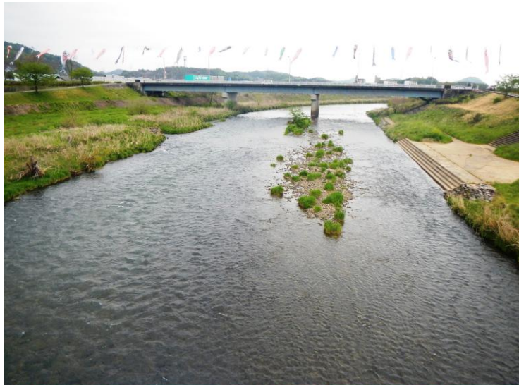
梅ノ木瀬橋上流
