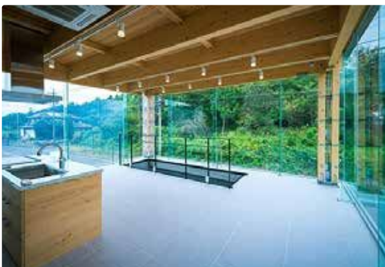
開放的な空間を実現「囲柱ラーメン木構造」は意匠性を高めます
