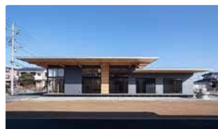
仕上げと構造を兼ねたAパネを室内外で現しに
