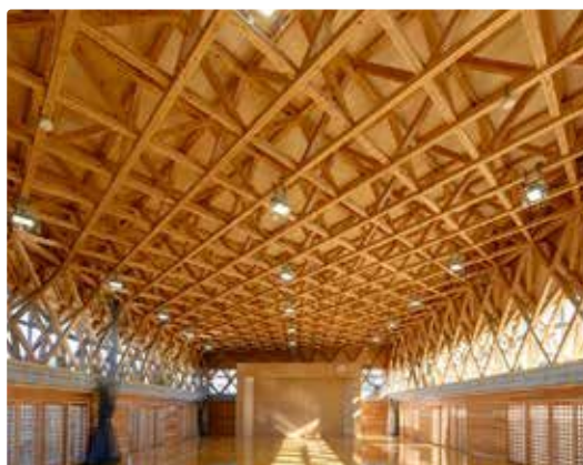
地域のヒノキ・スギの製材のみを使用した木組みの木造空間
