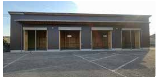
作業員も鉄骨造に比べて快適に業務が可能
