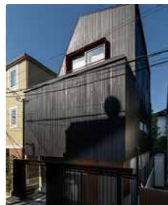
新宿区の準防火地域の木造 3 階建 2.3 階外壁全面に厚 30 焼スギをタテ張り
