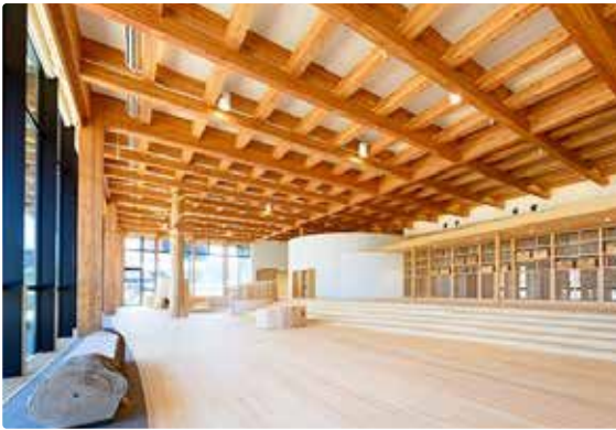
岐阜県産材を使用した格子組梁の準耐火建築物
