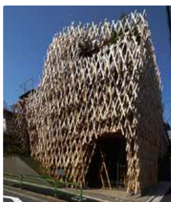
東濃桧を使用した店舗 製材から加工・施工までを行った
