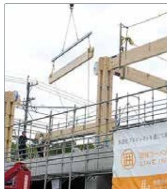
スピード感ある現場施工
