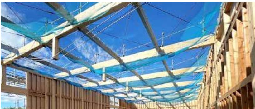
GWシステム建築 (GW1600+調弦梁) / 最大スパン 12.74m
