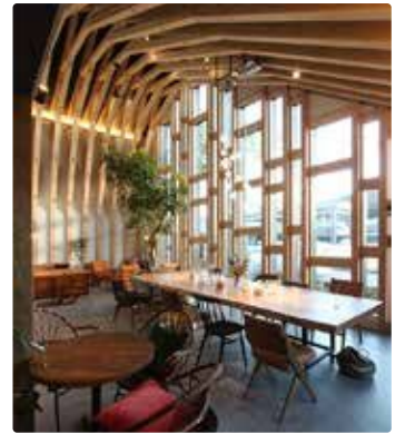
製材を使用した木組のトラス構造
