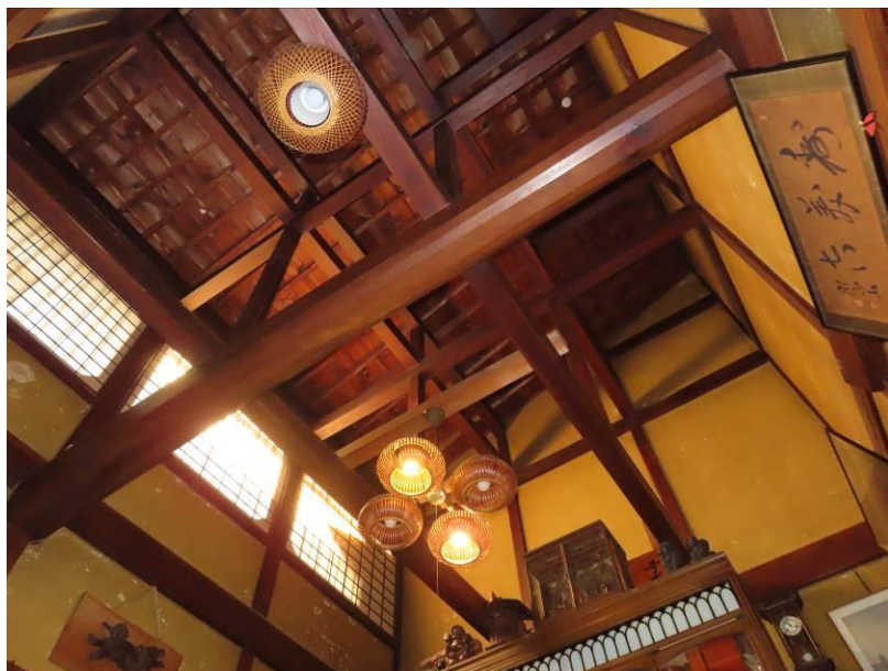
玄関ホール吹抜け（南西から）
