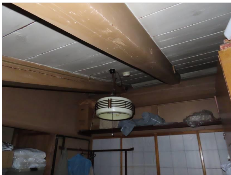
小屋組（東から）
