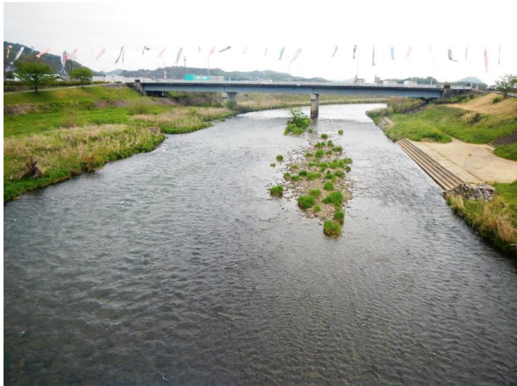
梅ノ木瀬橋上流
