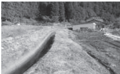
用水路の整備 (郡上市)
