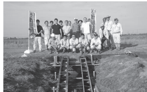
水田魚道の設置
