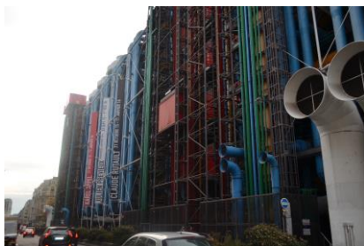
ポンプドール会館
