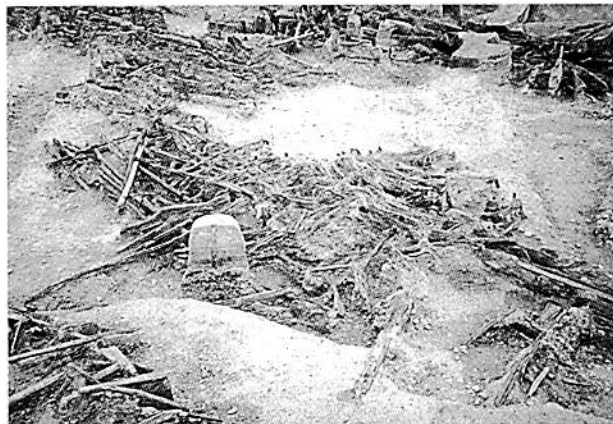
堤の基礎の木組み
