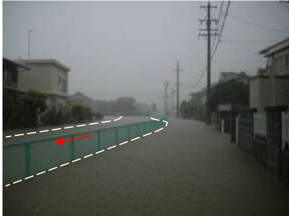
水門川浸水状況 (H25.9)
