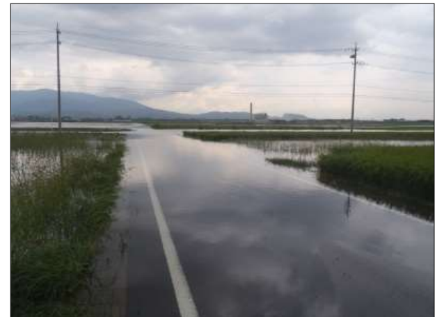
泥川水門上流の農地・道路冠水状況(H24.9)
