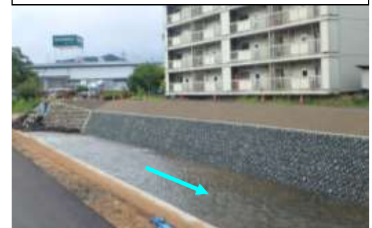
河川改修状況
