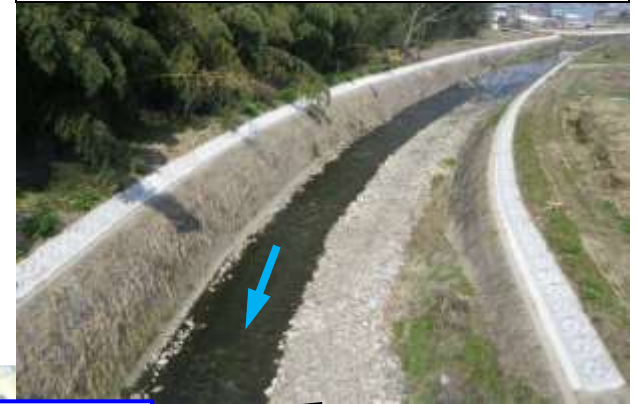
護岸工の状況
