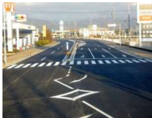
▲四車線化により交通が円滑化
