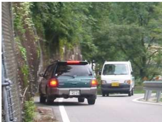
▲整備前はすれ違いが困難な隘路であった
