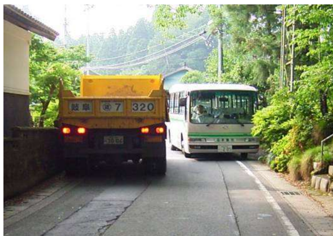
▲整備前は大型車のすれ違いが困難な隘路であった
