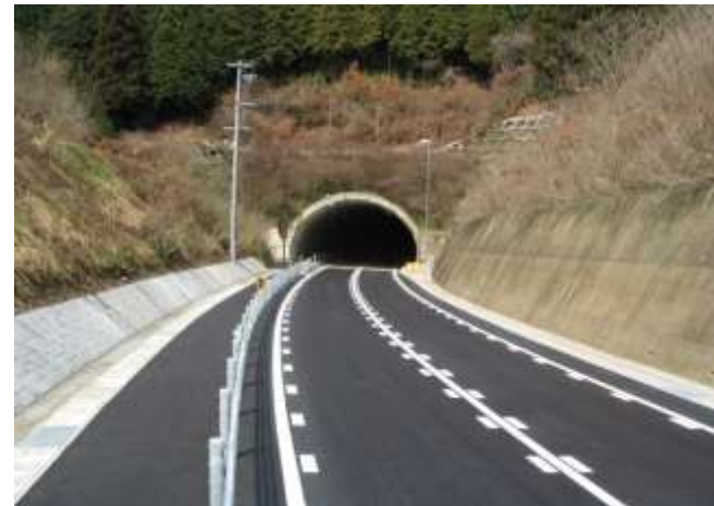
▲2号トンネル(下立トンネル)
