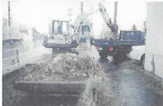
ゴミ除去の作業状況
