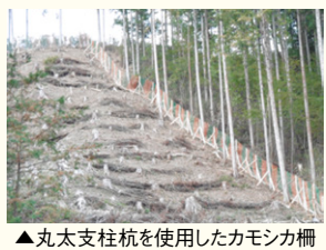
▲丸太支柱杭を使用したカモシカ柵
