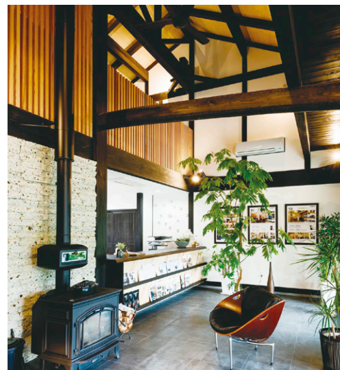
柱や梁などの構造材を仕上げとして見せた、 開放感あふれる玄関ホール
