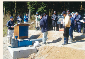
小水力発電による環境保全推進事業▶
