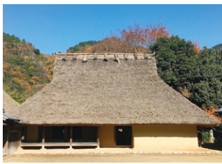
「箱木千年住宅」外観 日本最古の住宅と言われる建物。木の家の原型としてのヒントに満ちている。
