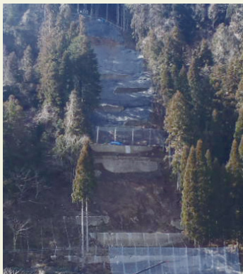
応急工事完了
