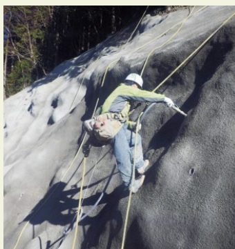
空隙充填工
