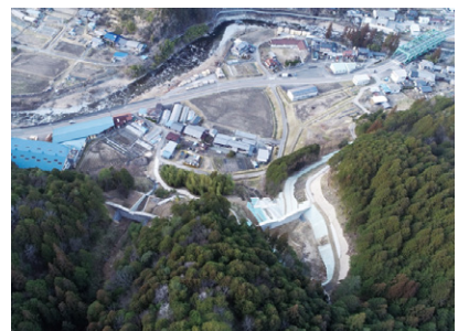
公共復旧治山事業 手掛岩2工事
