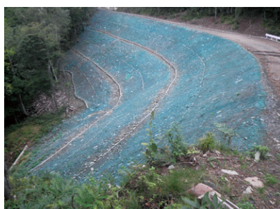
地方創生道整備交付金事業 白尾～鷺見線(4工区)
