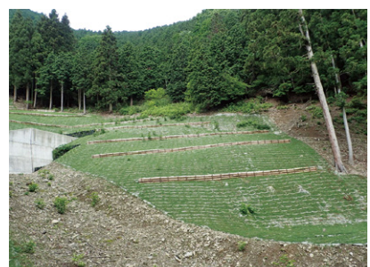
復旧治山事業 奥谷地区工事(補正)
