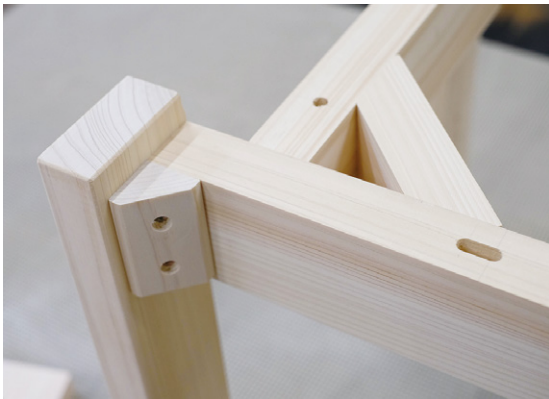
隅木（すみぎ）という補強を使い、構造を強くしている。
