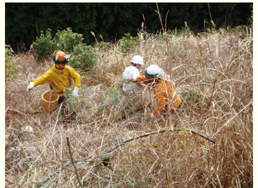
▲苦戦する「斜め張りネット」の撤去
