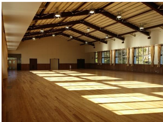
2階 多目的ホール
