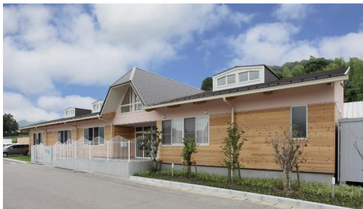
施設外観(北面)
