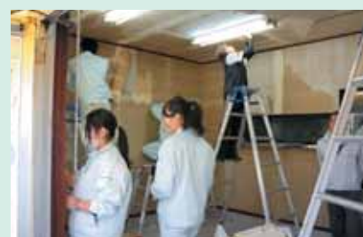
フラット岡食の内装作業の様子
