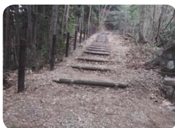
木質施設等の改修(郡上市内)
