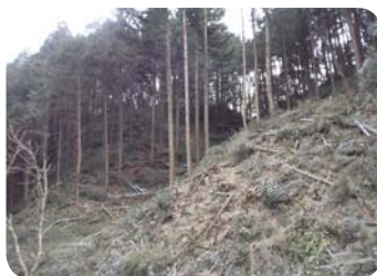
侵入竹の除去(関市内)
