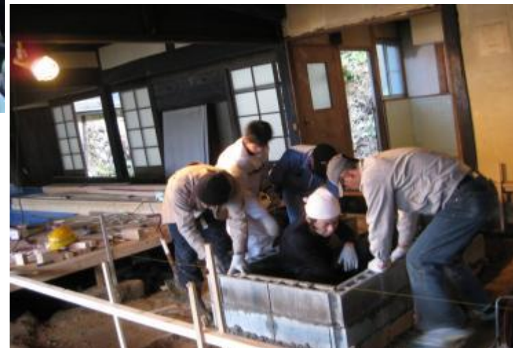
「囲炉裏基礎ブロック積研修」
