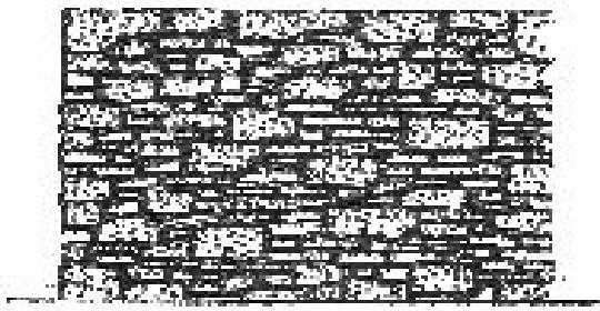
(2) 受注者は、天端石のある場合は、天端石に大きい石材を使用し、稜線が通るように施工しなければならない。
