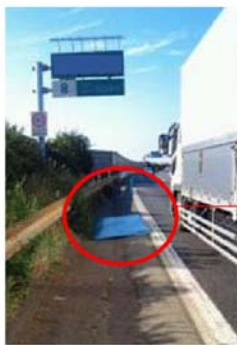
標識板補修用の重ね貼りシートの落下事例
