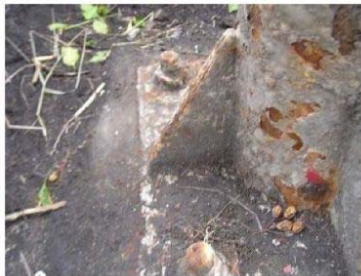
土砂や植生を取り除いた状態の例
