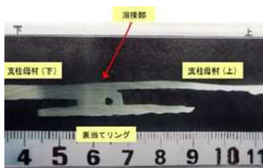
写真 2-1 内側から腐食した溶接継手部の断面マクロ写真
