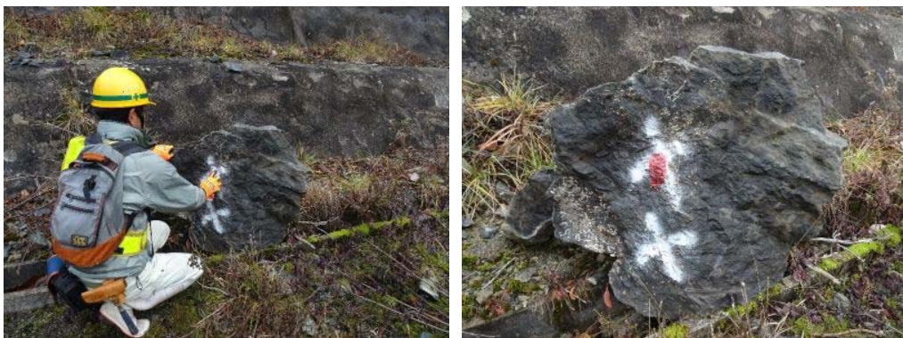
写 13-1 落石へのマーキング事例
