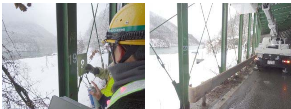
写 13-2 柱番号のマーキング
