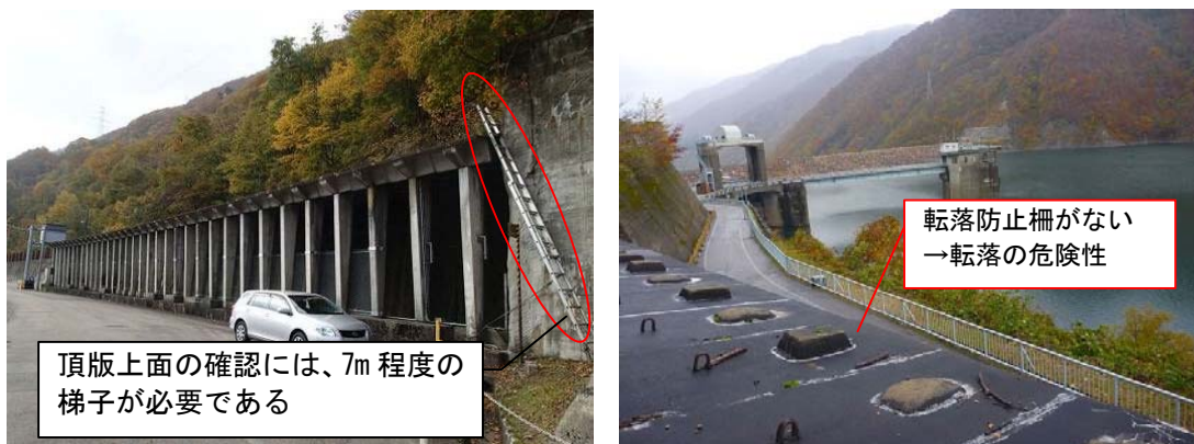
図 8-1 頂版上部点検時の安全確保
