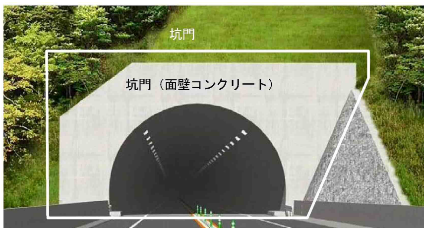
標準的な点検対象箇所（トンネル坑口部）
