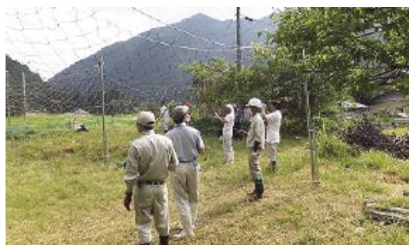
シカ被害対策「ドロップネット」の設置
