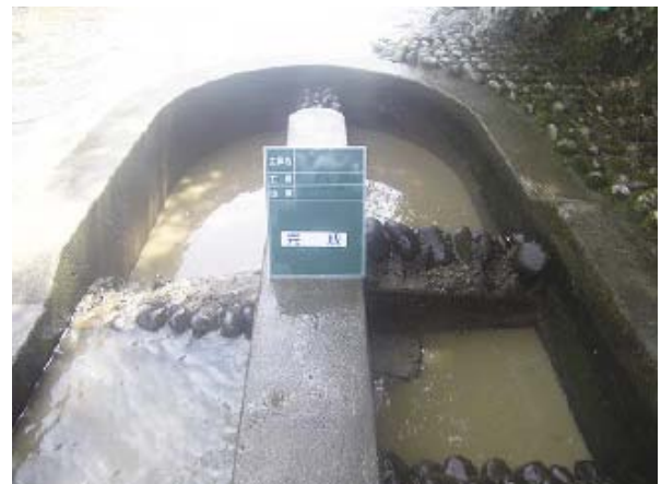
魚道の土砂撤去状況【左：撤去前 右：撤去後】(関市：小那比川)
