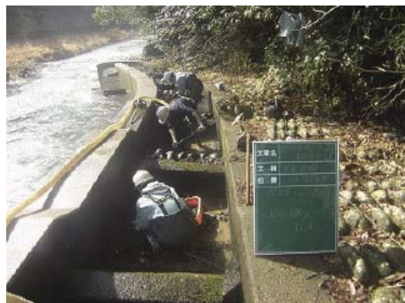
魚道の土砂撤去実施状況(関市：小那比川)
