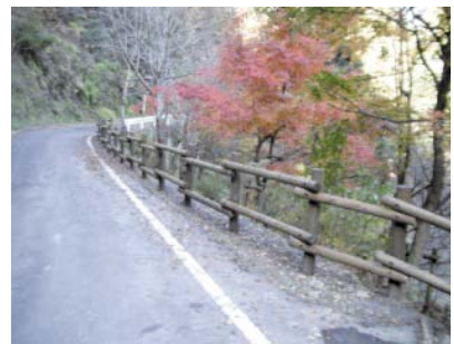
木質施設の改修(本巣市内)
