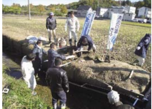
現場研修(参加者による魚道の設置)
