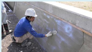
老朽化した水路壁のコーティング
