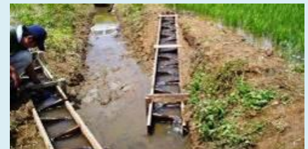
水田魚道の設置
