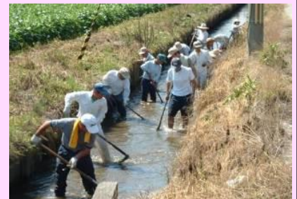
水路の泥上げ
