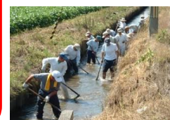
水路の泥上げ
