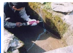
水路のひび割れ補修
