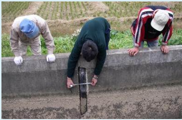
施設の機能診断
