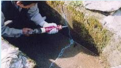
水路のひび割れ補修
