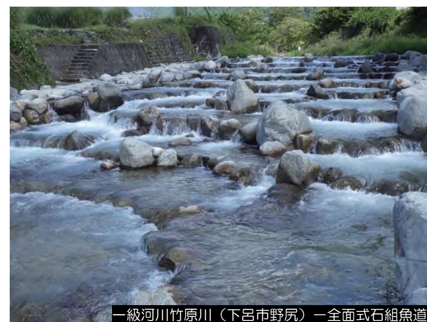
一級河川竹原川（下呂市野尻）一全面式石組魚道
