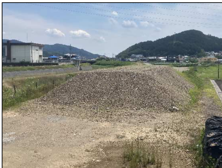
残土仮置き状況
