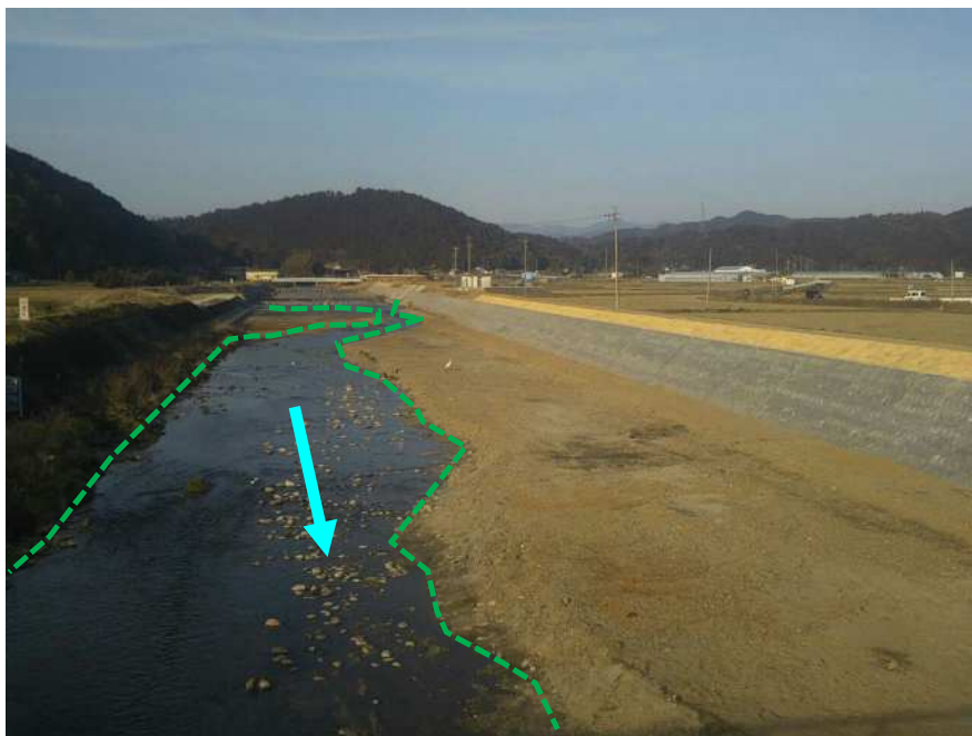
河床を元の形状に近い形で整備 (令和3年、整備時点)
