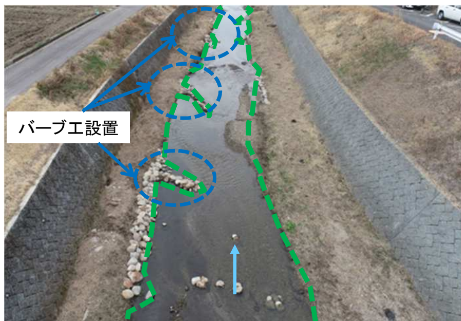
河床を元の形状に近い形で整備・ バークエ設置 (令和7年2月 整備時点)
