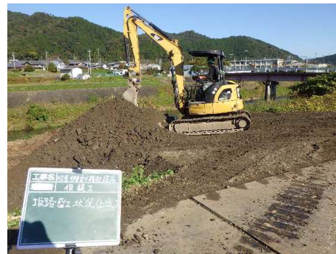
工事用道路への流用状況
