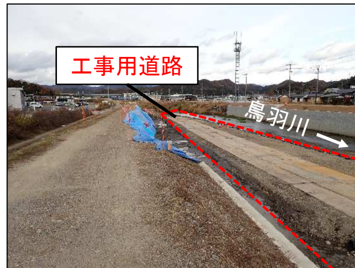
工事用道路への流用状況
