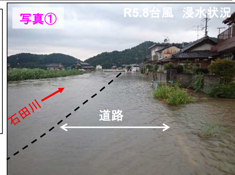
きたのにしやま 岐阜市北野西山地先(北側から南方向を撮影)
