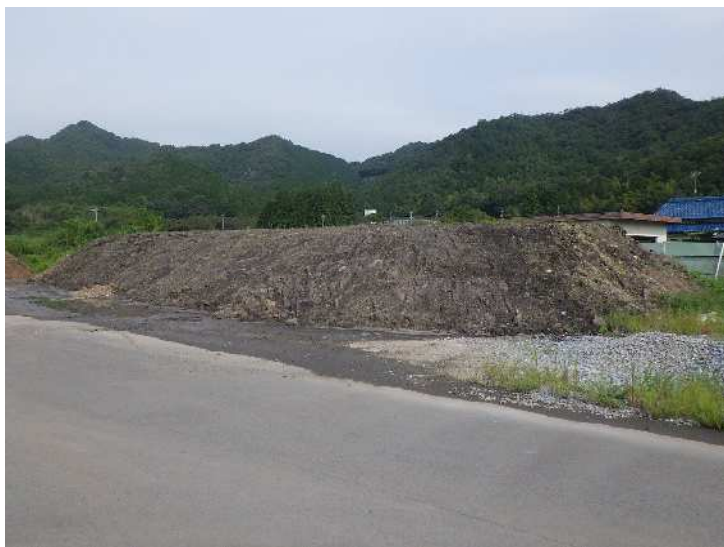
残土仮置き状況
