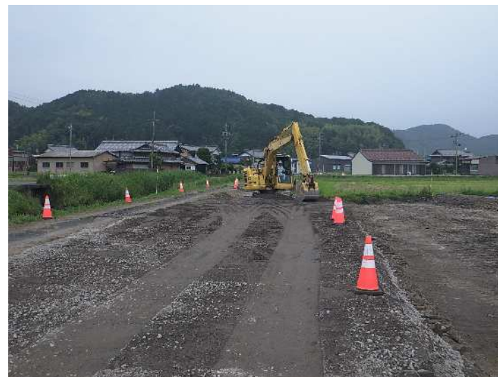
工事用道路への流用状況
