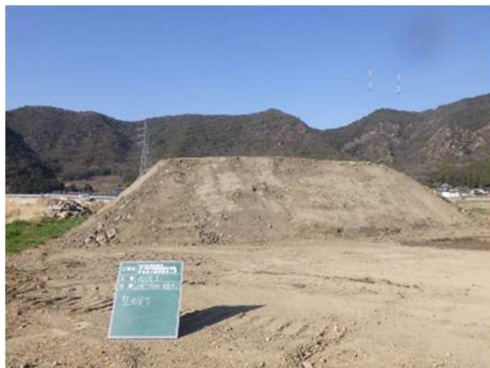
残土仮置き状況
