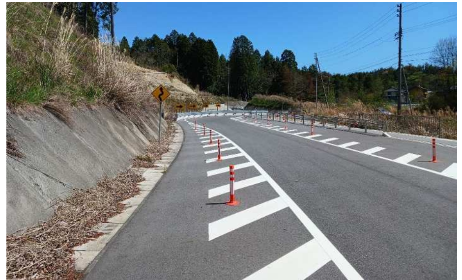
写真はイメージ（他現場施工例）
