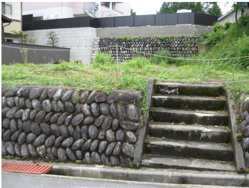
物件南西方向から撮影
