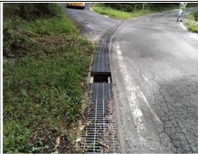
グレーチングが設置されていた箇所
