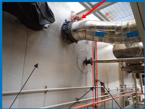
タービン建屋(壁面)
