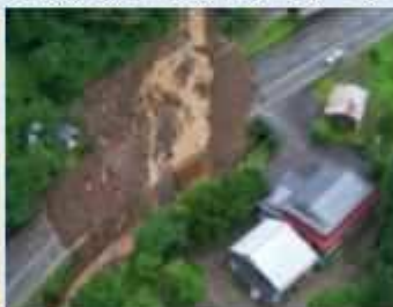
国道159号での土砂災害
