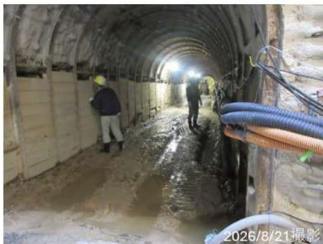
調査坑掘削状況
