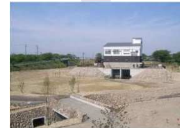
三井川 上戸排水機場完成
