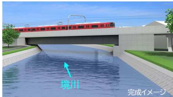
名鉄名古屋本線鉄道高架化事業に伴う 河道拡幅（岐阜市、岐南町）
