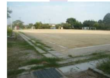
雨水貯留施設（各務原市立小学校）
