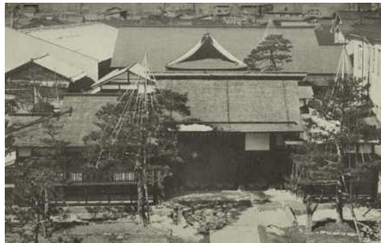
写真 3－15 第一次整備竣工後の高山陣屋
