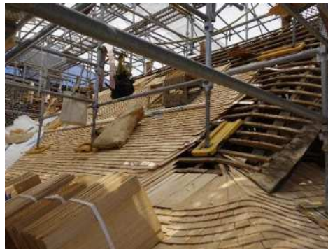
写真 8－2 屋根葺替工事の様子
