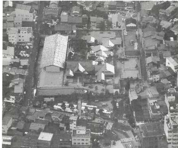
写真 3－21 第三次整備工事竣工 全景
