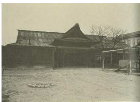
写真 3－10 玄関（右建物は裁判所）
