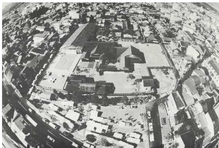
写真 3－18 第一次・第二次整備竣工 全景
