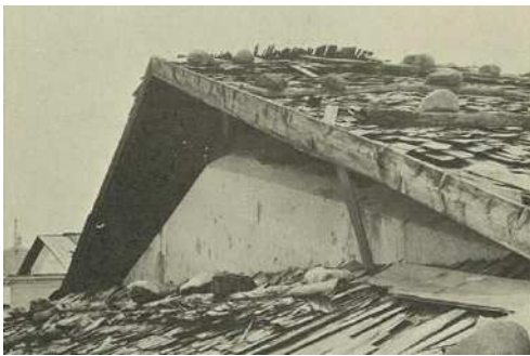
写真 3-13 御蔵東屋根（修理前）
