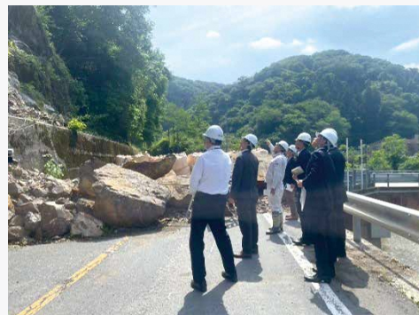
主要地方道名古屋多治見線の崩落現場を視察
