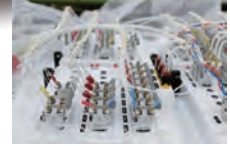
配電盤配線組立
