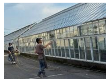
【遮熱塗布剤の散布状況】
