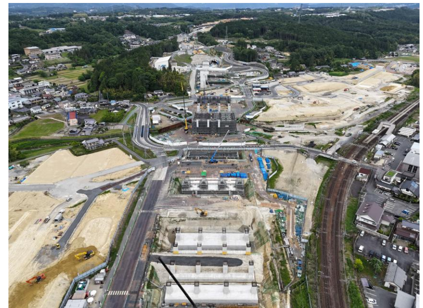
県内のリニア建設工事現場（リニア岐阜県駅）
