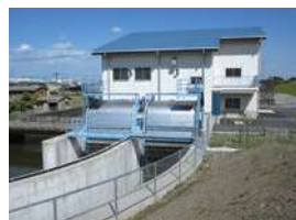
農業用排水機場
