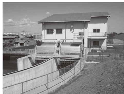
更新した鵜森排水機場(大垣市)
