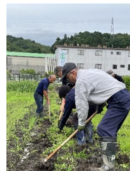
【明渠設置作業風景】
