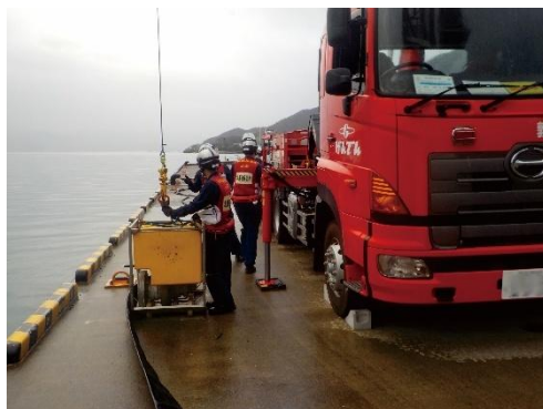
使用済燃料プールへの冷却水(海水)注水準備
