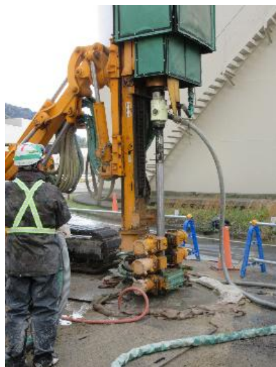
立坑の壁面防護・止水を目的とした地盤改良の様子
