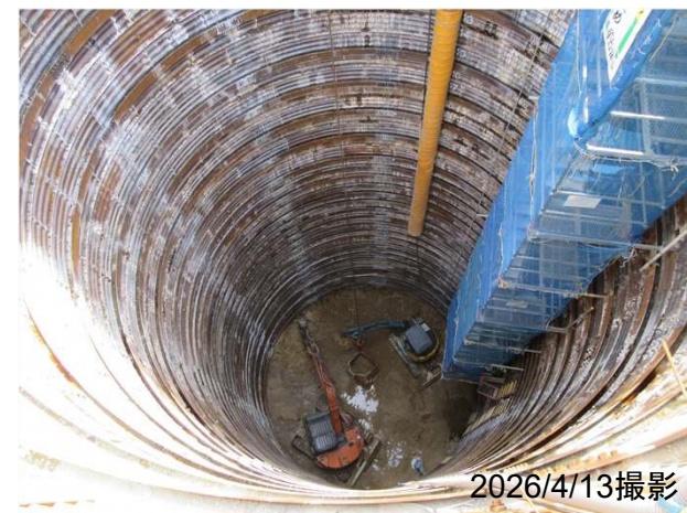
立坑の掘削(立坑内部)
