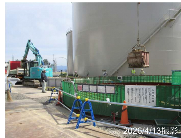
土砂の積み込み作業(地上作業)
