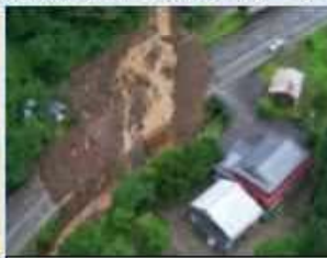
国道158号での土砂災害
