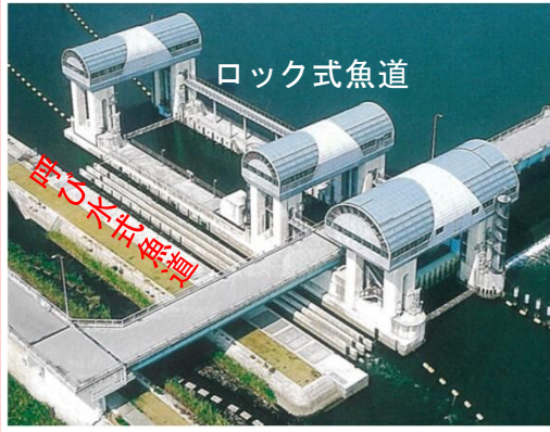
右岸ロック式魚道(閘門兼用) 右岸呼び水式魚道
